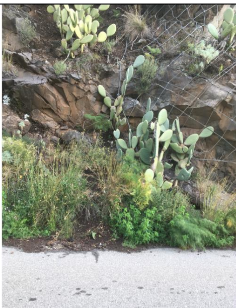
Rete a maglia larga, da rinforzare con ancoraggi e necessità di sottomurazione fra bordo inferiore rete e muro di blocchi e malta di cemento nella parte finale (Foto 11, 12 e 13)
