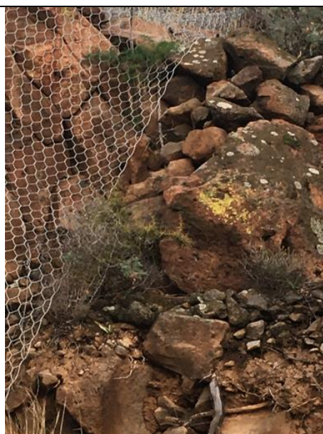
Rete esagonale leggera da rinforzare con funi o pannelli (Foto 5 e 6)
