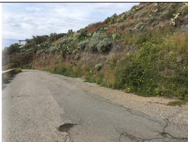
Rete leggera che necessita di pulizia e rinfianco di funi ed ancoraggi di irrobustimento (Foto 18)
