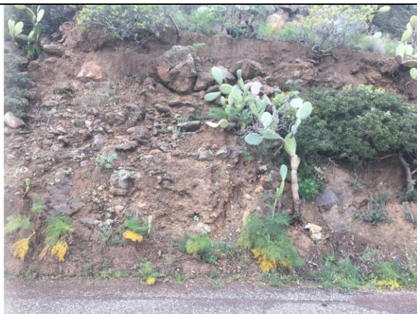
Tratto in località Canale da presidiare con nuova rete leggera da irrobustire con funi ancorate (Foto 43)
