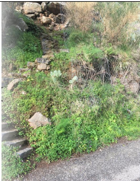
Rete esagonale leggera da rinforzare con funi o pannelli (Foto 9 e 10)
