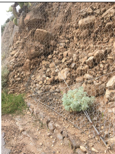
Punta Stimpagnato Rete leggera da svuotare a tratti con aperture locali e sarciture poiché già rinforzata con funi ancorate (Foto 29)
