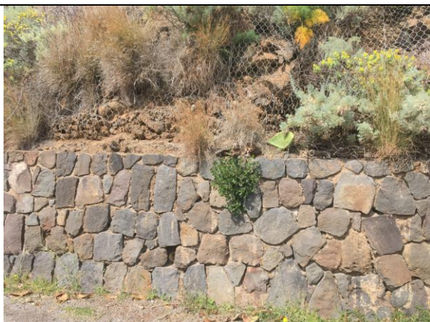
Rete leggera da svuotare e rinforzare con funi ancorate e muretta al piede dove possibile (Foto 38, 39 e 40)
