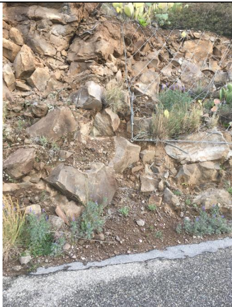
Rete a maglia larga da rinforzare con ancoraggi (Foto 7 e 8)
